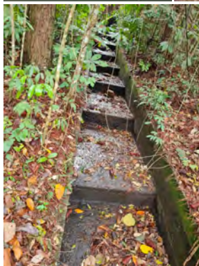
Rampas e escadas hidráulicas | lagos Centauro, Xarais e Fênix-Orion | imagens Morais, 2026 | lago Xarais, imagem Google Earth.
