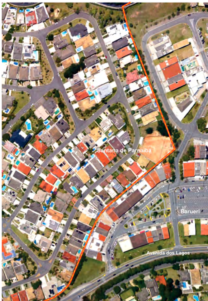
limites municipais / trecho 4b: muro de segurança da Morada das Flores.
